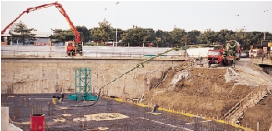
Bétonnage d'un radier étanche avec un béton adjuvant de MAPEFLUID PZ500
