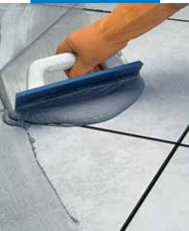
Jointoiment de carrelage en sol à l'aide d'une spatule en caoutchouc
