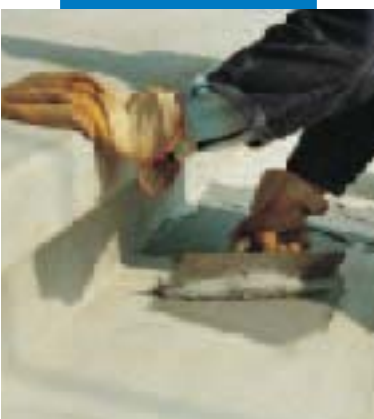
Application d'Adesilex PG1 pour collage de gradins préfabriqués
