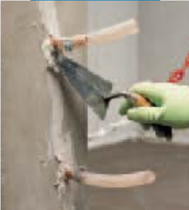
Fixation de tubes d'injection
