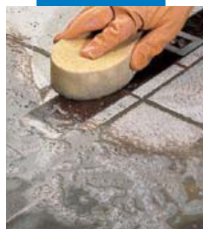
Finition à l'éponge, de carrelage avec insertion de bois
