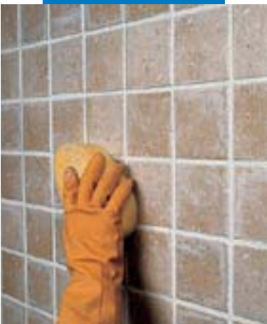
Finition des joints à l'éponge
