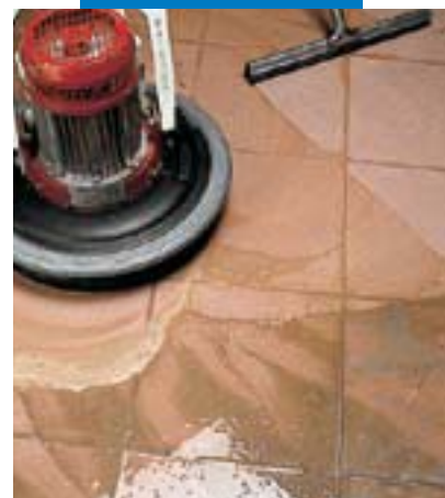
Finition des joints de grès cérame à la raclette et à la mono-brosse
