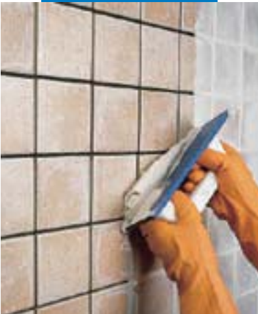
Jointoiment de faïence à l'aide d'une spatule
