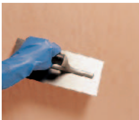
Effet vénitien: glaçage de Silexcolor Marmorino avec l'arête de la lisseuse tenue à angle ouvert
