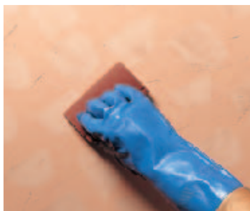
Effet vénitien: ponçage entre les passes de Silexcolor Marmorino avec un papier de verre à grain fin
