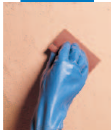
Effet encaustique: ponçage de Silexcolor Marmorino avec un papier de verre à grain fin
