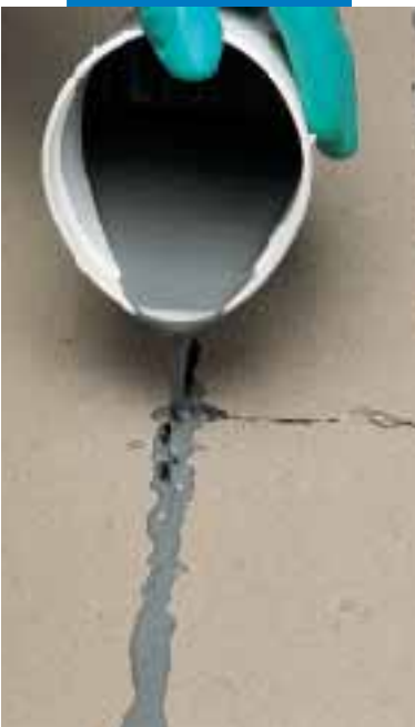
Réparation d'une fissure de chape ciment avec Eporip
