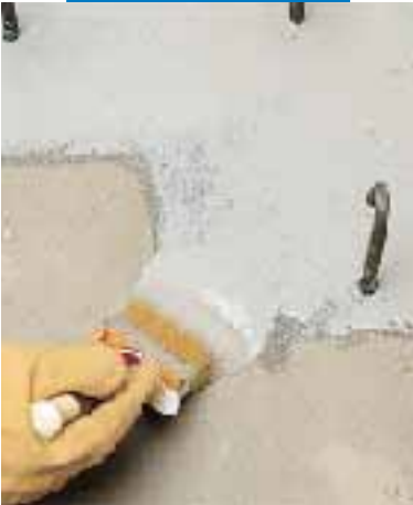
Application d'Eporip pour reprise de bétonnage
