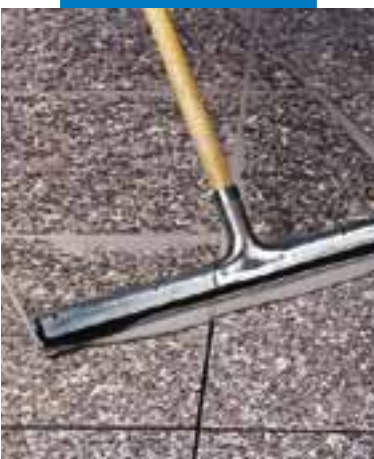
Jointoiment en sol de granit poli
