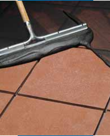
Jointoiement de terre cuite en sol à l'aide d'une raclette
