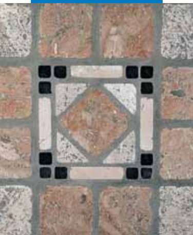
Exemple de jointoiment entre éléments de pierre naturelle vieillie
