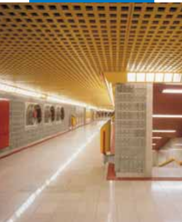
Pose de Granitello dans le métropolitain - Ligne 3 - Milano (Italie)
