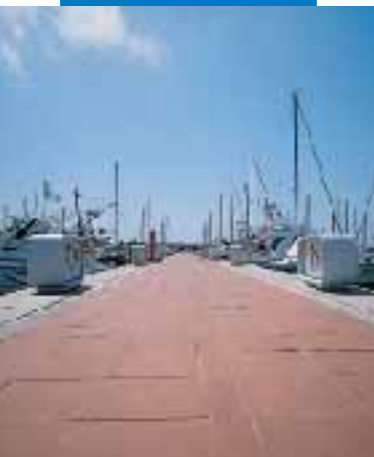
Pose de sols en pierre naturelle
