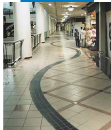
Pose de carrelage dans un centre commercial - Filinvest Festival Superhall - Manila (Philippines)
