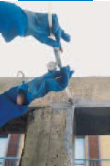
Poutres renforcées avec des plaques métalliques
