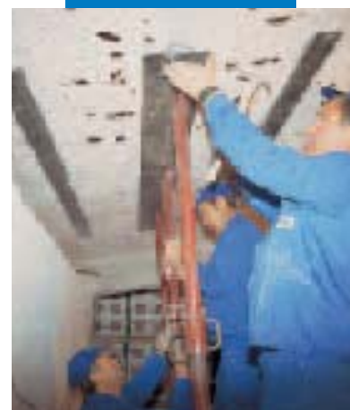
Renforcement de structures par plaquage métallique
