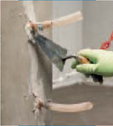
Fixation de tubes d'injection
