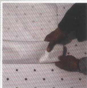
3. Pose de la couche filtrante (facultative)
