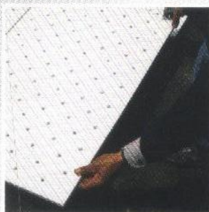
2. Pose de POLYDRAIN sur l'étanchéité
