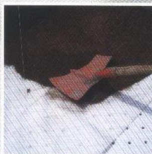
4. Pose de la terre végétale
