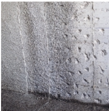
Piquage du support avant application du mortier adjuvanté avec IDROSILEX
