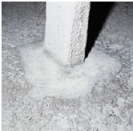
Pilier imperméabilisé avec IDROSILEX
