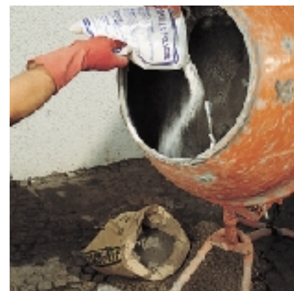
Préparation du mortier idrofuge adjuvanté avec la POUDRE IDROSILEX
