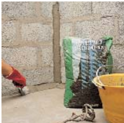
Préparation des angles avec IDROSILEX PRONTO
