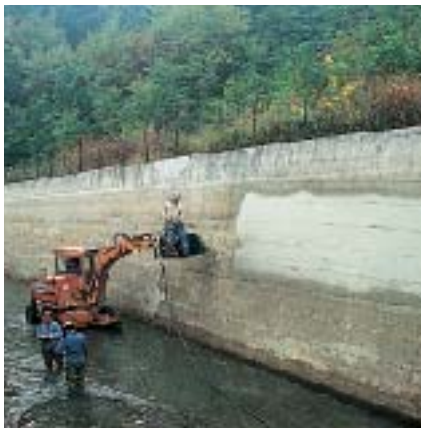
Application par projection sur les parois d'un canal
