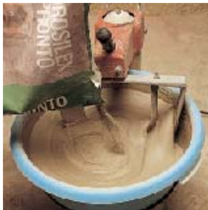
Gâchage d'IDROSILEX PRONTO
