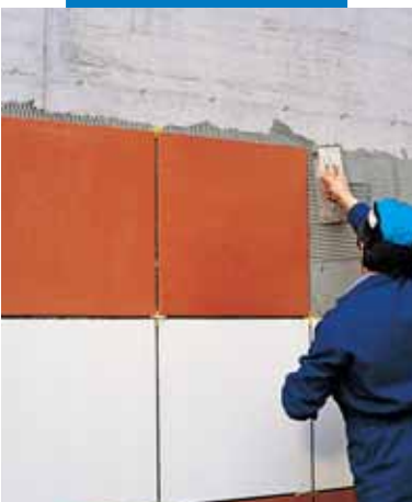
Pose de carreaux de grands formats avec Kerabond+Isolastic
