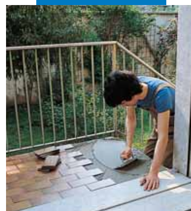
Complément d'imperméabilisation et collage avec Kerabond+Isolastic
