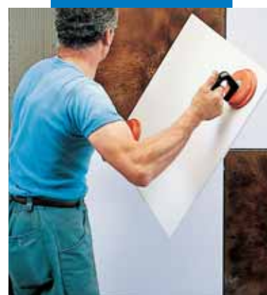
Pose de Keraion sur parois
