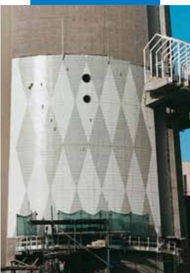
Pose de grès étiré sur béton avec Kerabond + Isolastic - Nouvelle tour des télécommunications - Kuwait City (Kuwait)
