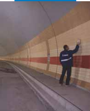
Tunnel Mrázovka - Prague - République Tchèque
