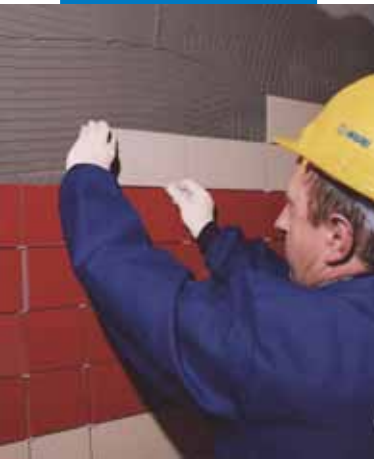
Pose de carrelages en céramique sur des murs
