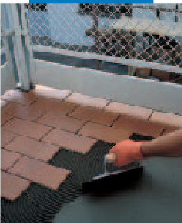
Pose de carrelage avec Granirapid sur un balcon imperméabilisé à l'aide de Mapelastic
