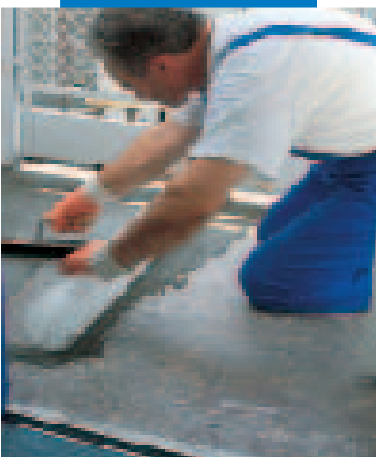
Imperméabilisation d'un balcon avec Mapelastic et application d'un treillis en fibre de verre
