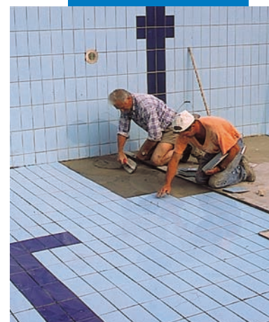
Pose de carrelage sur Mapelastic
