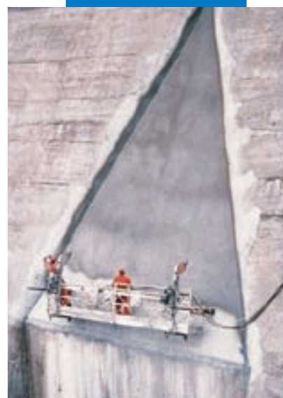
Exemple d'application par projection de Mapelastic sur un barrage
