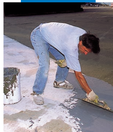
Imperméabilisation d'une piscine avec Mapelastic
