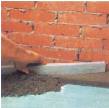
Application d'une chape ciment adjuvantée de PLANICRETE
