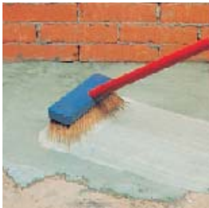
Application d'une barbotine d'accrochage adjuvantée de PLANICRETE
