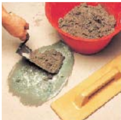
Réparation d'une chape: application du mortier
