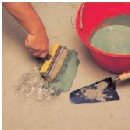
Réparation d'une chape: application de la barbotine
