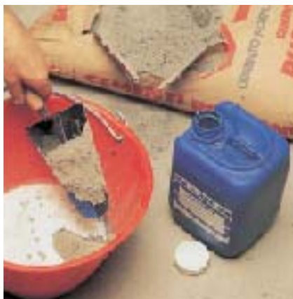
Préparation de mortier adjuvanté de PLANICRETE
