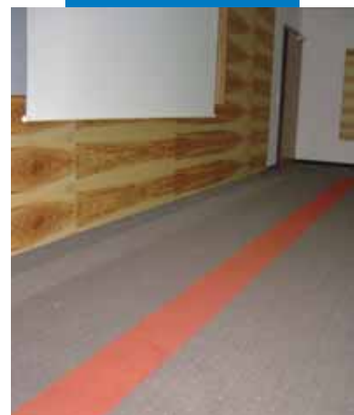
Application de Primer G préalablement à la réalisation d'Ultraplan Eco, puis de la colle Rollcoll pour le collage de moquette dans des chambres de l'hôtel Villa Hotel Castellani - Autriche
